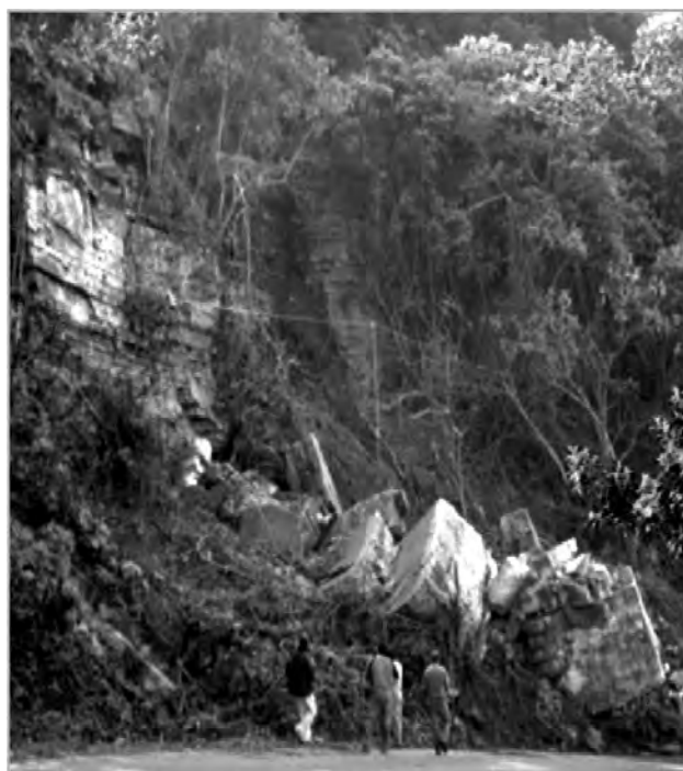
Figura 1. Inestabilidad de una ladera en la Sierra Norte de Puebla.
