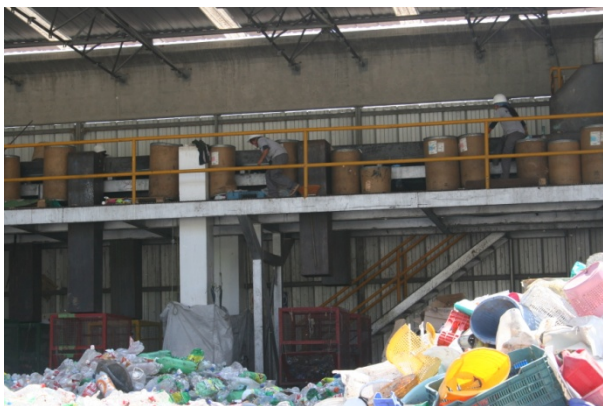
Planta de separación del relleno sanitario "Chiltepeque" Organismo Operador del servicio de Limpia del Municipio de Puebla.
